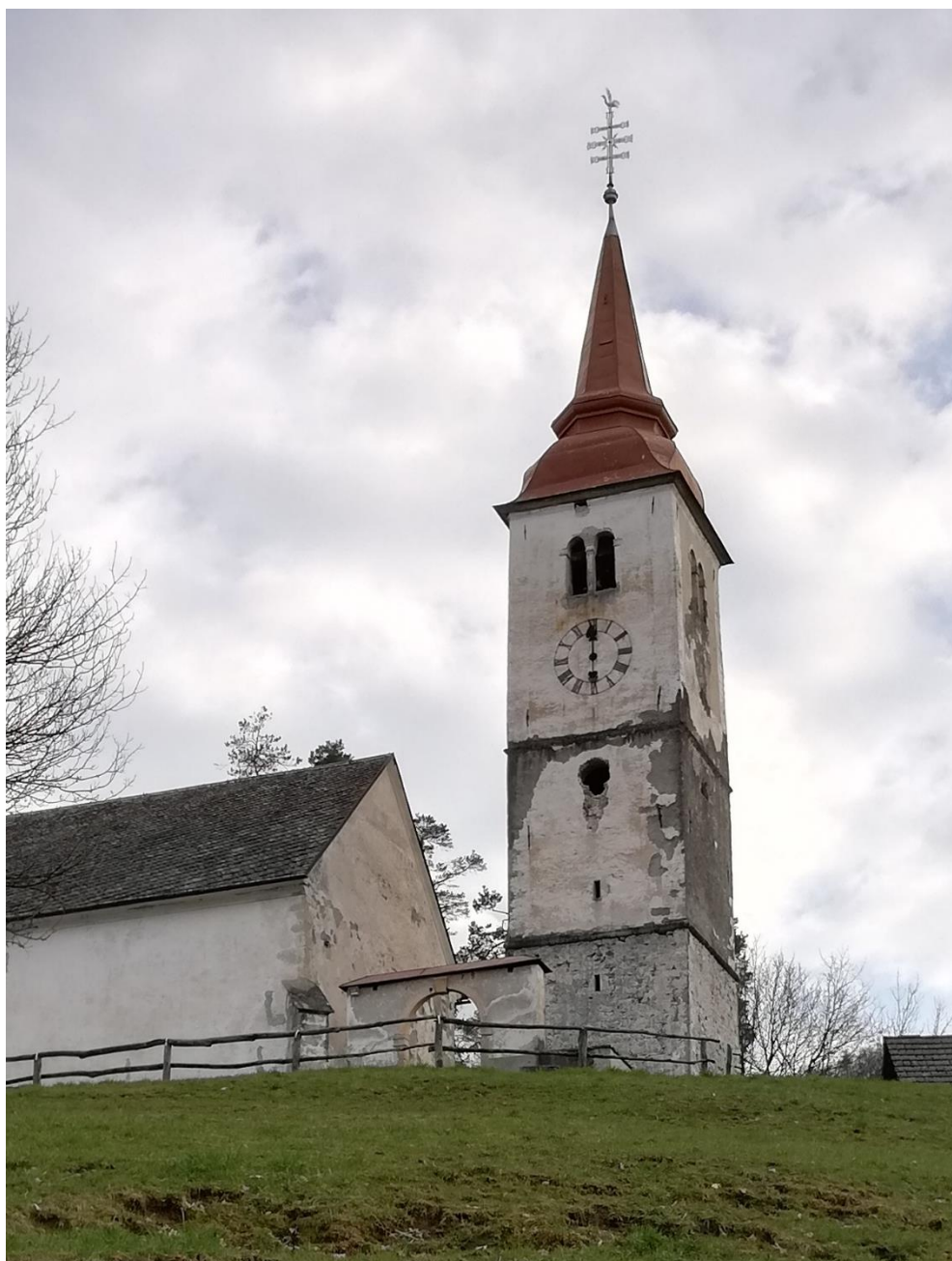
Slika 1: Zvonik po sondiranju fasade in odstranitev strehe med zvonikom in cerkvijo.
