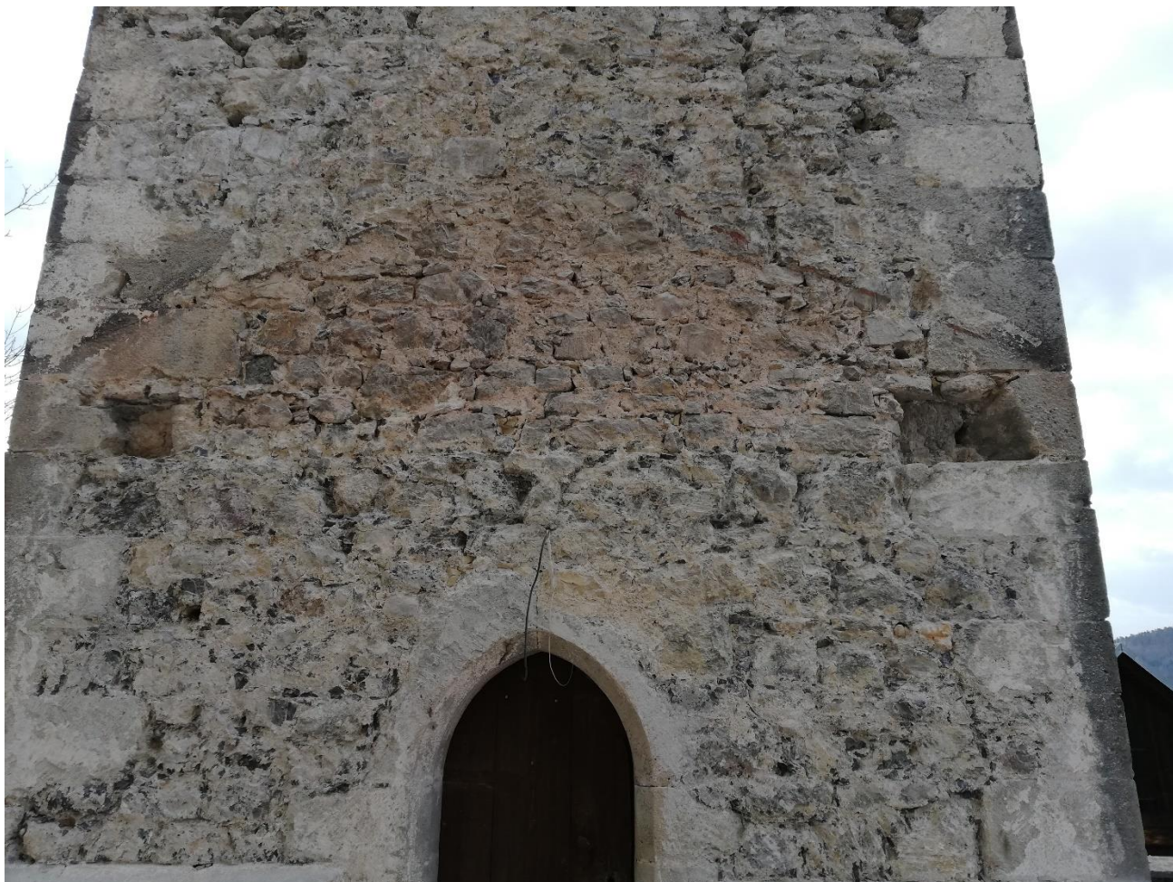
Slika 9: Detajl nastavkov za spodnje lega strehe v zvoniku.
