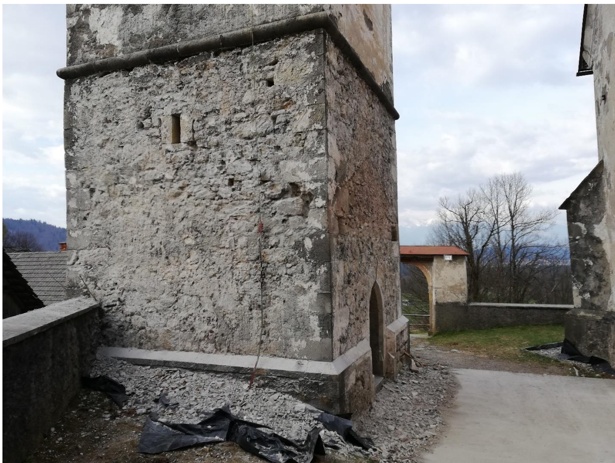
Slika 7: Sondiranje fasade na južni in zahodni strani zvonika s prehodom med zvonikom in cerkvijo po odstranjeni strehi.
