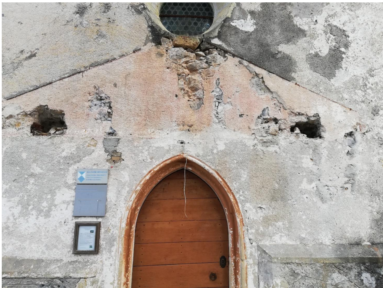
Slika 10: Detajl nastavkov za spodnje lega strehe v zidu cerkve (ladje).
