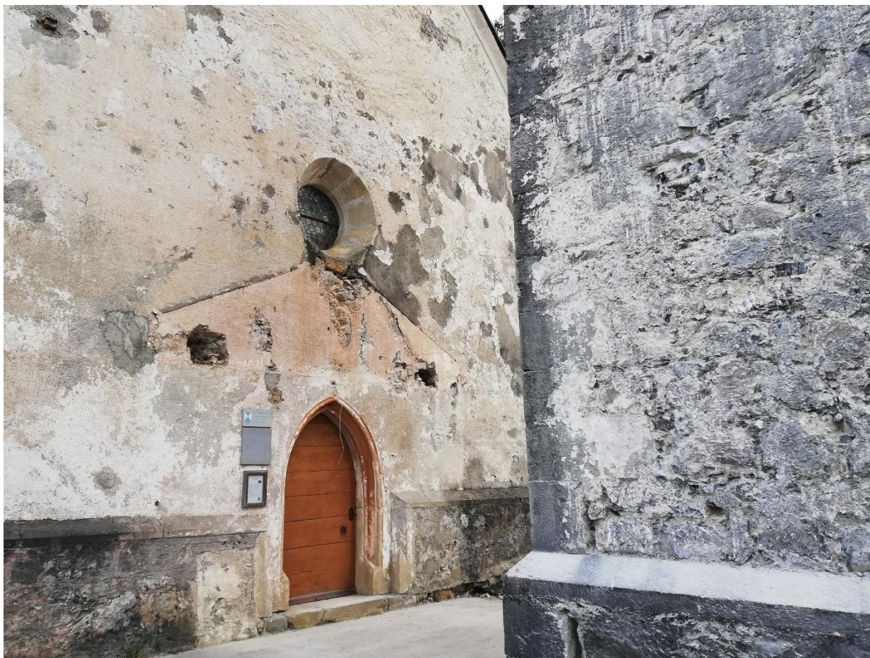
Slika 5: Odstranjena je streha med zvonikom in cerkvijo zato, da se lahko postavi oder okoli zvonika.
