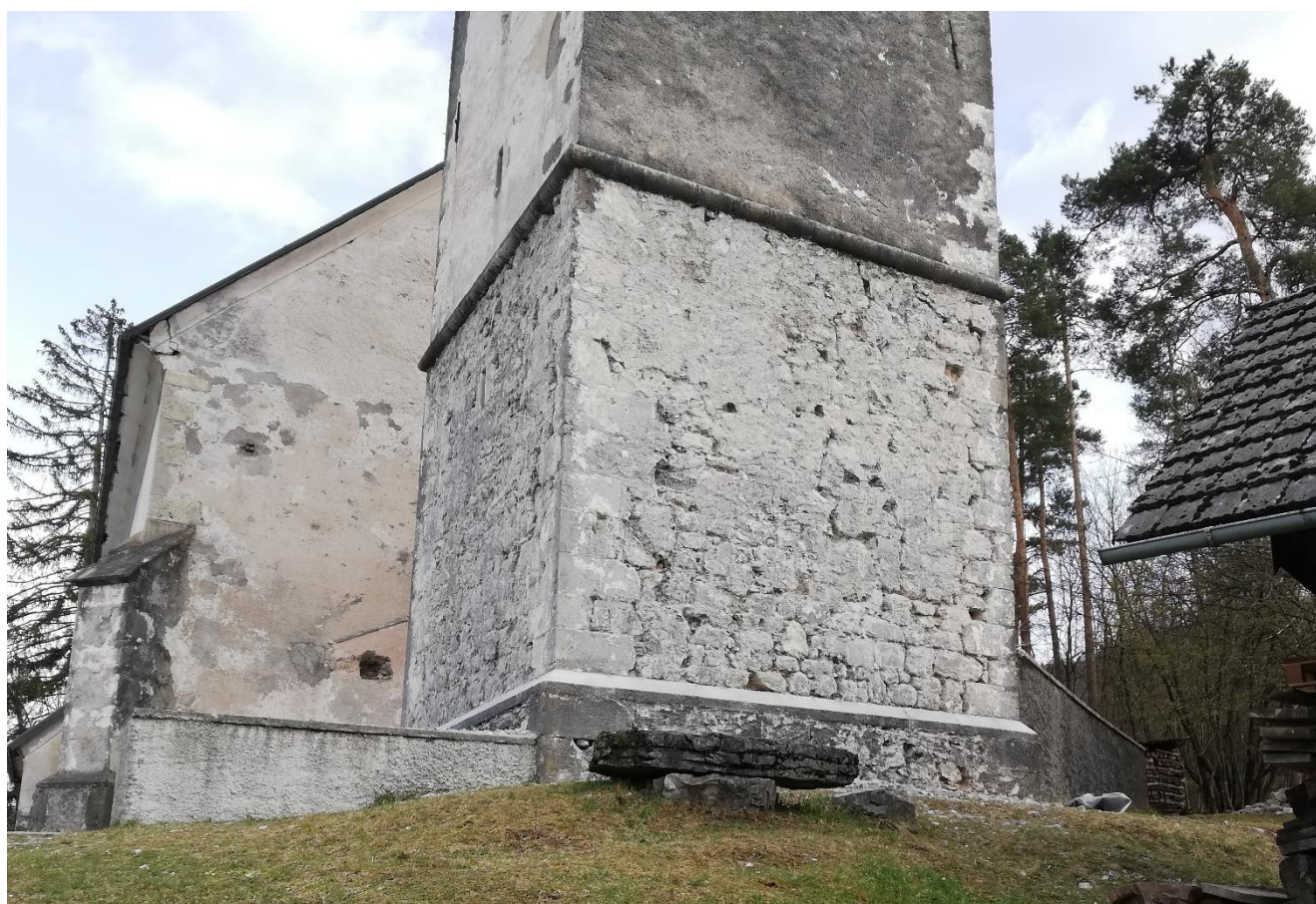
Slika 3: Severna in vzhodna stran zvonika fasada sondirana do prvega kamnitega robu.
